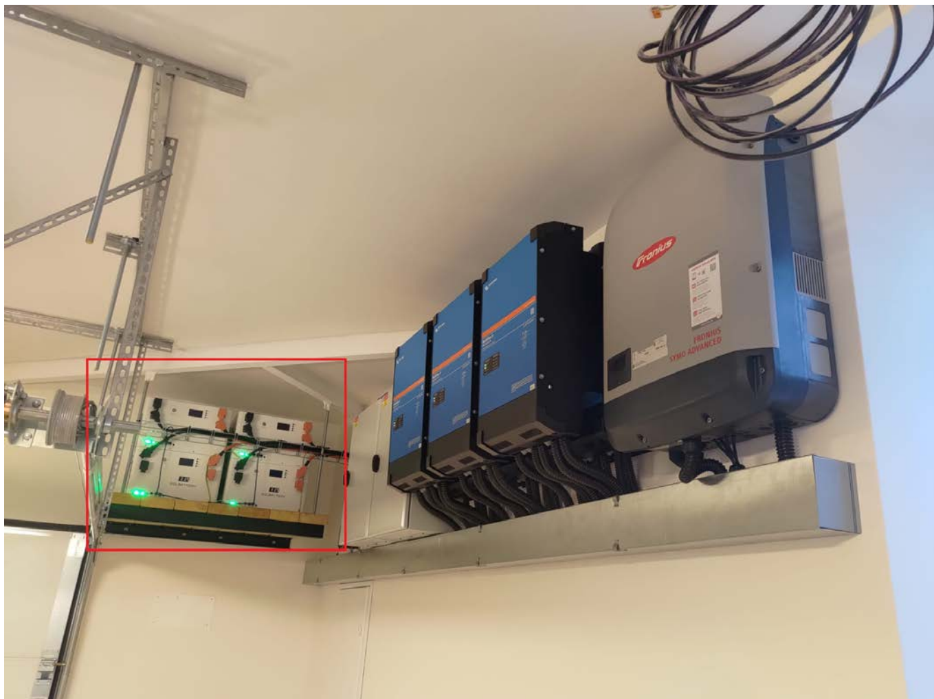
Obr. 6 Baterie 3x 14,34kWh 51,2V
