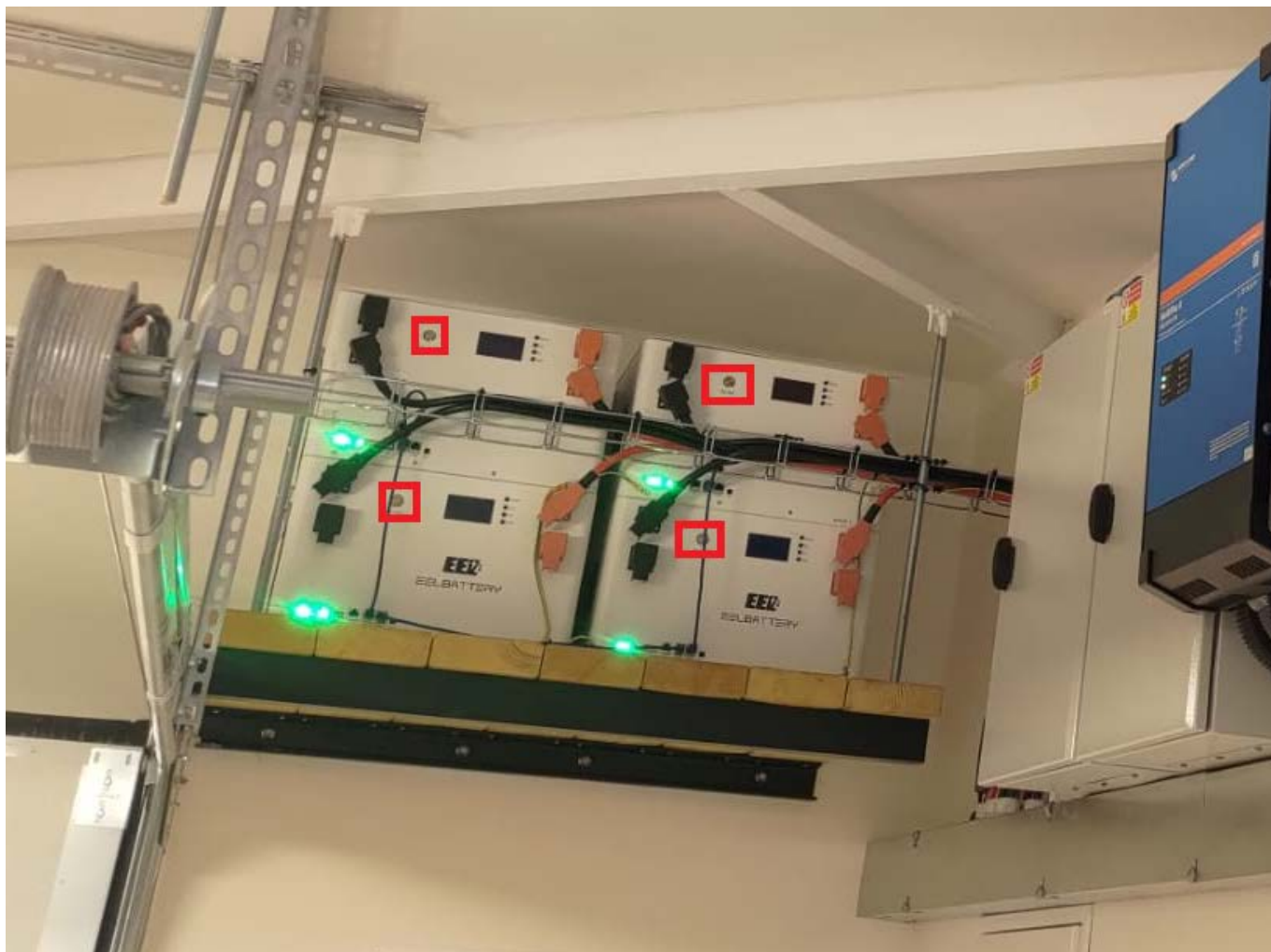
Obr. 14 Tlačítko pro vypnutí baterií
