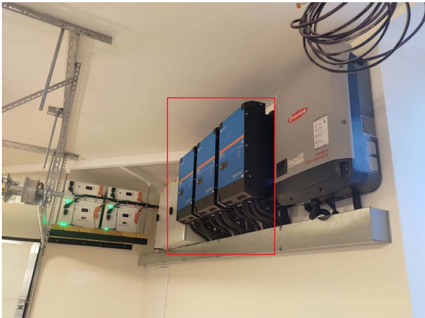
Obr. 5 Hybridní střídače Victron Energy MultiPlus-II 48V/5000VA
